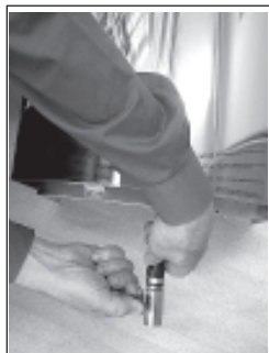
Beim Öffnen der Düse den Schlauch nach unten in einen Eimer richten. Vorsichtig arbeiten! Das Wasser ist sehr heiß!
